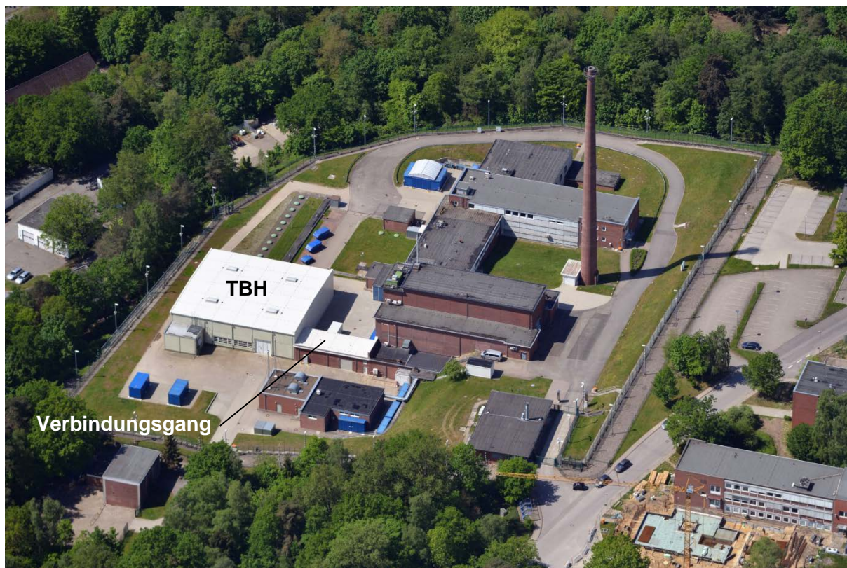
Abbildung 6-1: Luftbild (aus Richtung Osten) auf das Anlagengelände mit FRG, HL, der „neuen“ Versuchshalle bzw. TBH und dem Verbindungsgang (Stand: 2016)
